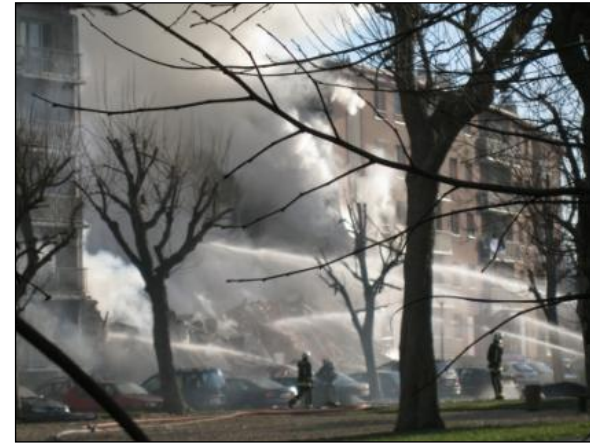
Noisy-le-Sec (93) le 22/12/2007 Effondrement d'un immeuble
